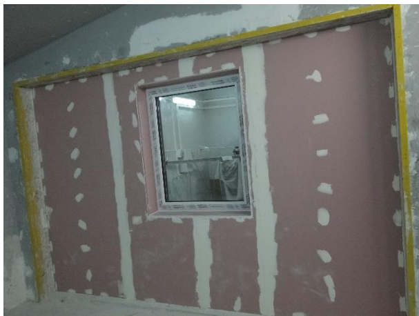
Rys. 4. Lekka ściana szkieletowa z oknem zamontowana na stanowisku badawczym ITB.
